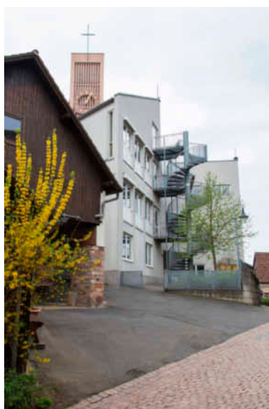
Laufach bekommt eine Tagespflegestätte im Pfarrzentrum (graues Gebäude).
