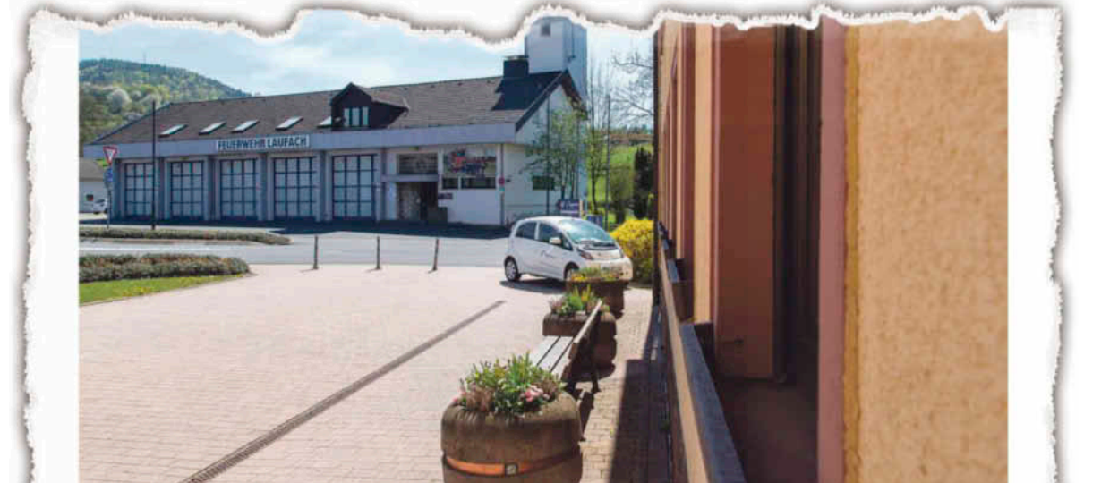
Feuerwehrhaus (links) und Rathaus (rechts) bilden in Laufach künftig eine Einheit. Das Domizil der Wehr wird abgerissen. An gleicher Stelle entsteht ein Neubau. Dieser wird durch einen Anbau mit dem Rathaus verbunden. Das hat der Gemeinderat einstimmig beschlossen. Foto: Christian Münstermann
