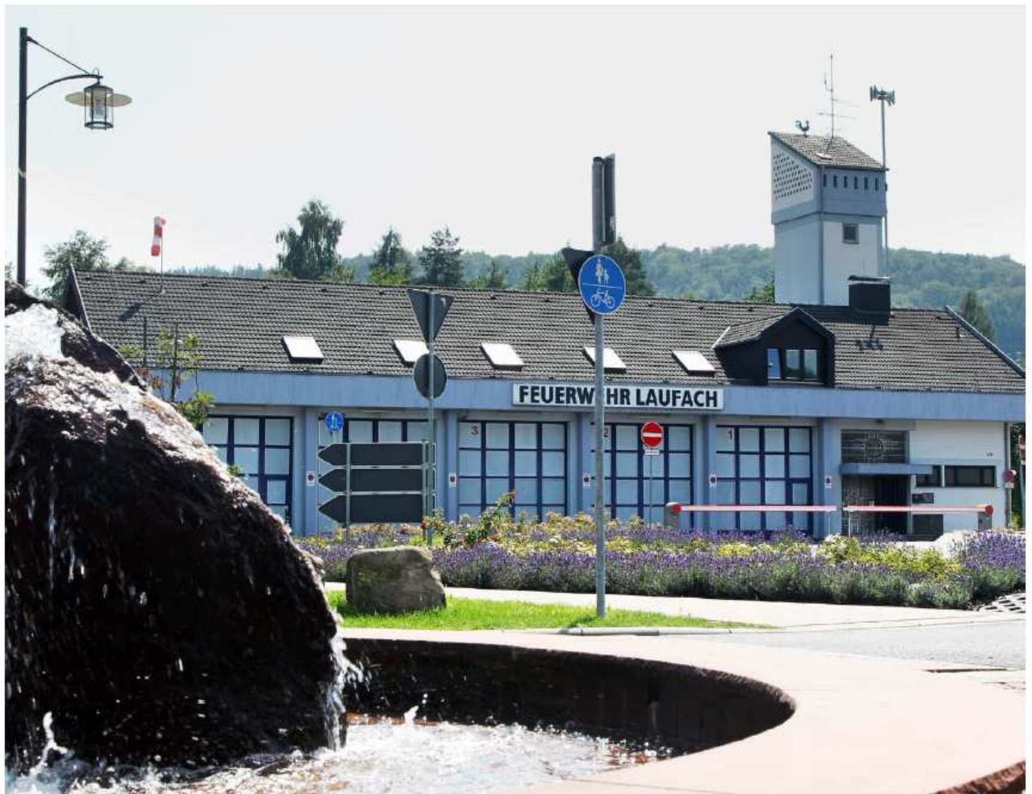
Soll saniert und erweitert werden: das Feuerwehrgerätehaus in Laufach.
